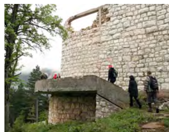
SLIKA 25 Dolazak na srušenu zgradu žičare na Vidikovcu
