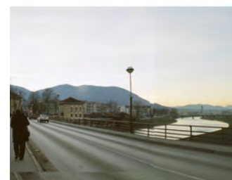
SLIKA 36 Prelazak mosta na rijeci Željeznici
