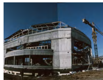
SLIKA 23 Izgradnja olimpijskog bazena u naselju Otoka
