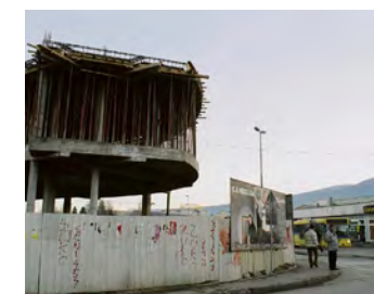
SLIKA 35 Izgradnja šoping centra na Ilidži
