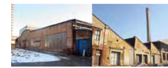
SLIKA 14 Poslijeratni izgled nekada željezničke radionice 'Vaso Miskin Crni'
