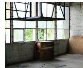
SLIKA 35 U zgradi donje stanice žičare. Nakon mjesec dana kabine su izmještene iz zgrade
